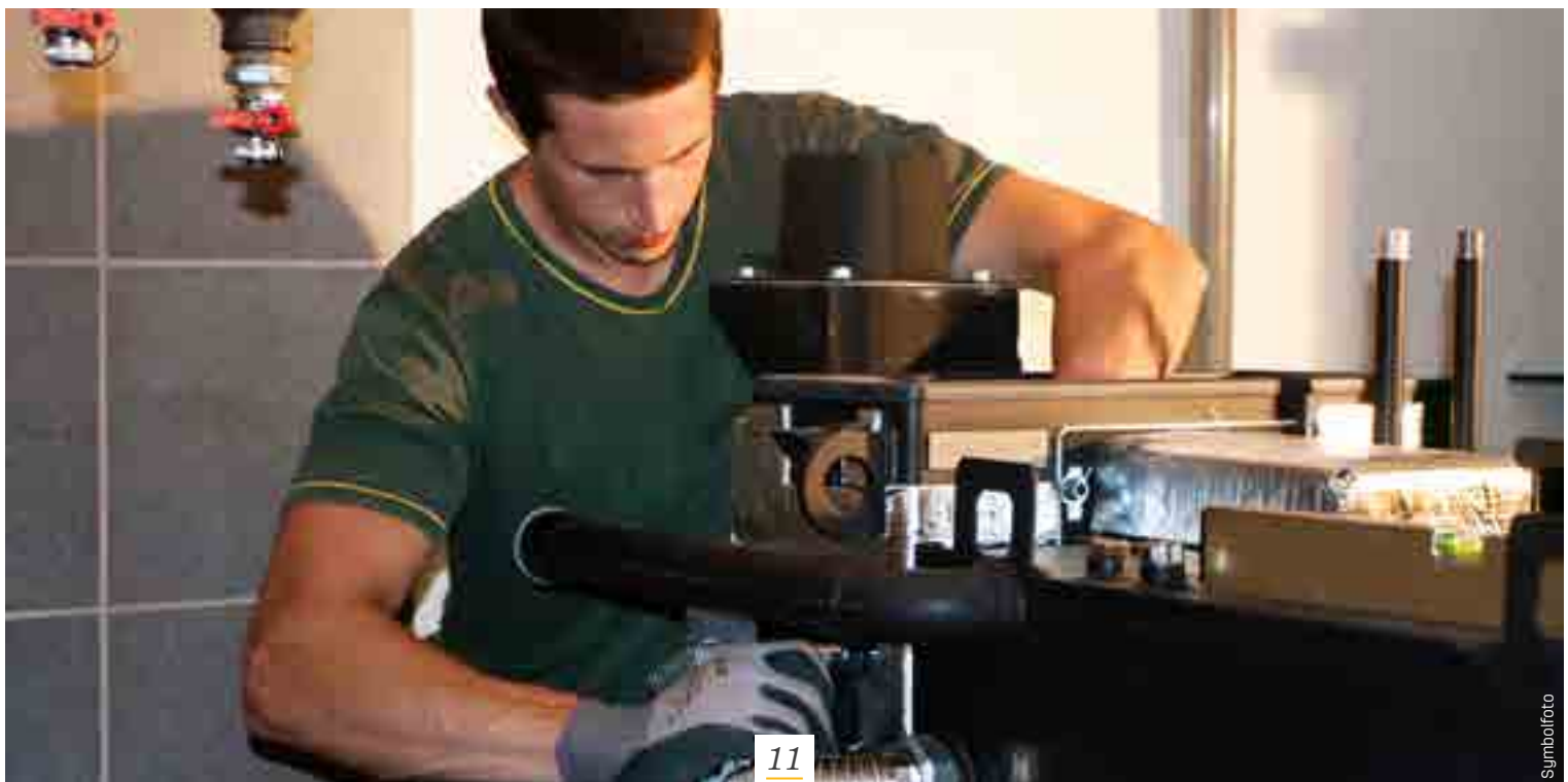
KWB Easyfire – Kessel in 2 Teile zerlegbar
